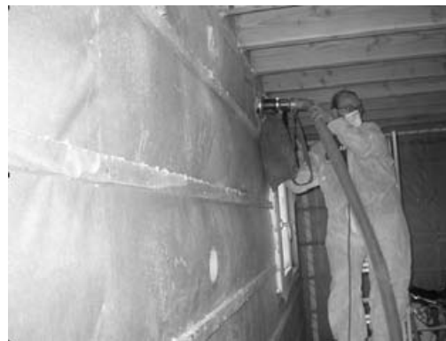
Exemples de réalisation en insufflation
