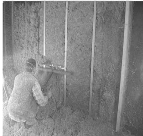
Exemples de réalisation de projection humide.
