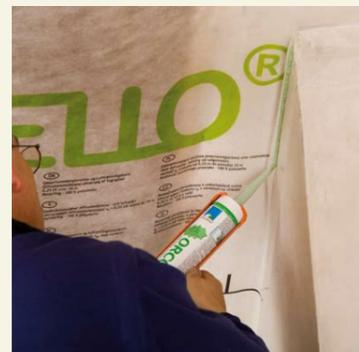
Pour les raccords à des cheminées isolées à double paroi, laisser dépasser INTELLO d'environ 3 cm sur la cheminée. Appliquer un cordon de colle ORCON F d'environ 5 mm de diamètre et poser la bande avec une boucle de dilatation dans le lit de colle. Ne pas écraser complètement la colle.
