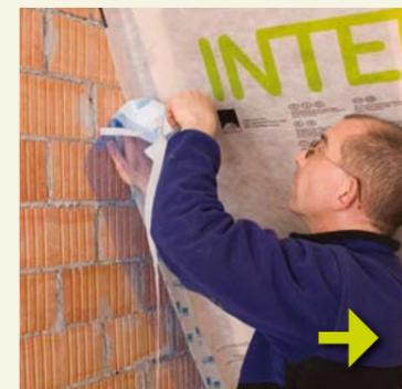
Sur la maçonnerie qui doit encore être enduite, la bande de raccord à un enduit CONTEGA PV garanti des raccords précis et étanches à l'air. La bande est d'abord fixée avec son propre ruban adhésif sur la face lisse du freine-vapeur.
