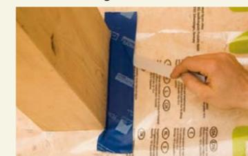
Dans une seconde phase, il suffit alors d'enlever les bandes de séparation restantes pour réaliser le raccord dans son intégralité.
