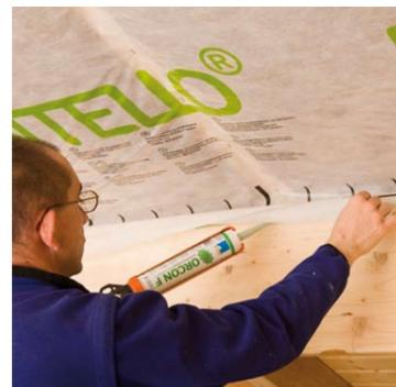
Sur les chevrons ou pannes dont le bois est encore rugueux, utiliser la colle de raccord ORCON F. Appliquer ORCON F en un cordon d'un diamètre d'environ 5 mm. Sur les supports rugueux, augmenter éventuellement le diamètre du cordon de colle.
