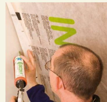
Pour le raccord à un mur pignon enduit, appliquer la colle de raccord tout usage ORCON F directement avec la cartouche, en un cordon d'un diamètre d'environ 5 mm. Sur les supports rugueux, augmenter éventuellement le diamètre du cordon de colle.
