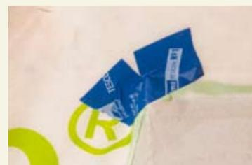
Réaliser l'étanchéité des coins avec de petits bouts de TESCON N°1. Inciser le ruban adhésif au milieu, sur la moitié de sa largeur. Ainsi, il épouse facilement la forme du coin.
