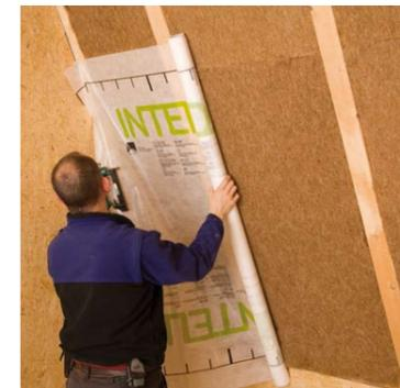
La bande freine-vapeur et d'étanchéité à l'air INTELLO se pose sous l'isolation thermique, du côté intérieur. Le collage à l'aide de rubans adhésifs devrait se faire sur la face lisse imprimée. Les agrafes devraient avoir une largeur de 10 mm et une longueur de 8 mm et être placées à une distance maximale de 10 à 15 cm.
