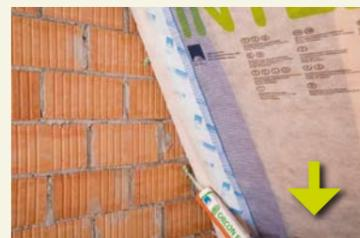
Ensuite, rabattre le non-tissé blanc étanche à l'air avec l'armature d'enduit bleue intégrée et fixer celui-ci à la maçonnerie, le plus loin possible dans le coin, par quelques points de colle ORCON F.
