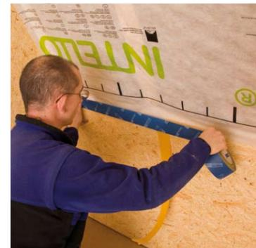
Les raccords aux éléments de construction adjacents sont tout aussi importants que le collage des chevauchements. Pour le raccord avec des éléments de construction lisses non minéraux (comme ici la jambette en panneaux OSB), utiliser le ruban adhésif TESCON N°1. Procéder de même pour le raccord à un mur pignon.
