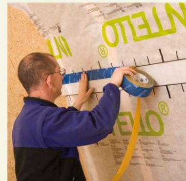
Coller le freine-vapeur après sa mise en place. Au niveau des chevauchements, coller les bandes à l'aide du ruban adhésif TESCON N°1, sans exercer de traction ni de charge. Ne pas appliquer de ruban adhésif par-dessus des plis au niveau du chevauchement, mais ouvrir ceux-ci avant de les recoller. Centrer le ruban et le frotter pour qu'il adhère bien, p.ex. à l'aide de la spatule pro clima PRESSFIX.
