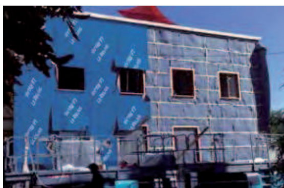
Isolation thermique par l'extérieur
