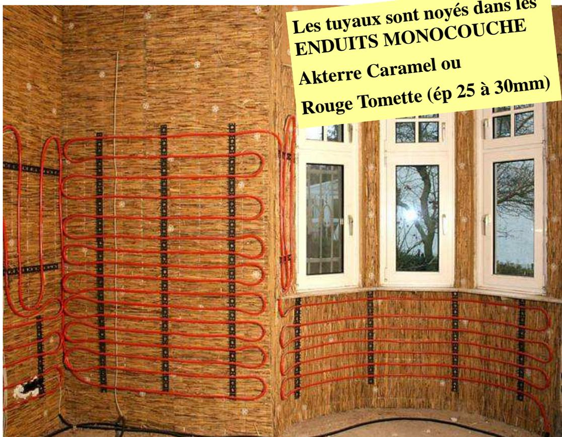
**Le rail présente un système de clips pour fixer facilement à la paroi les tuyaux du mur chauffant tous les 5 cm.
