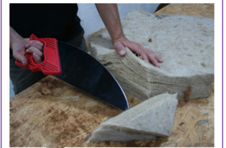
Découpe impeccable d'un isolant flexible fibreux avec le couteau à lame courbe. Aiguisage régulier à prévoir.
