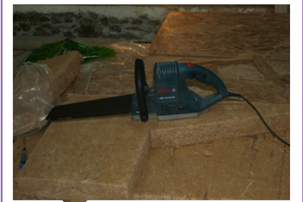
La scie alligator (ici Bosch) est l'outil le plus pratique et le plus efficace pour la découpe des isolants. On se sert d'un panneau entier comme " martyr " pour faire la découpe dessus.
