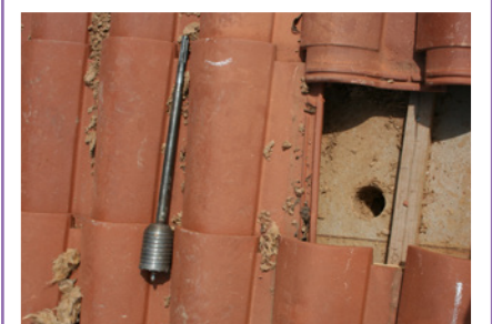
Scie trépan : 420 mm d'isolants rigide et flexible percés facilement et proprement afin de créer un passage de gaine par exemple.
