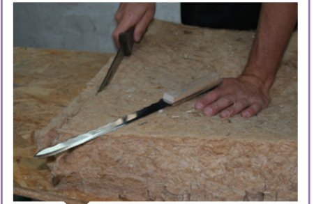
Deux couteaux de marques différentes. Attention à leur longueur : 10 cm d'écart entre les deux modèles qui feront la différence pour les fortes épaisseurs !
