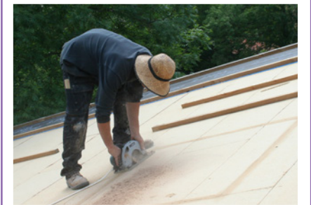
La scie circulaire, incontournable pour découper les panneaux rigides.
