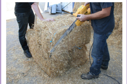
Pour découper les bottes de paille, la scie alligator (ici Dewalt) fonctionne parfaitement.
