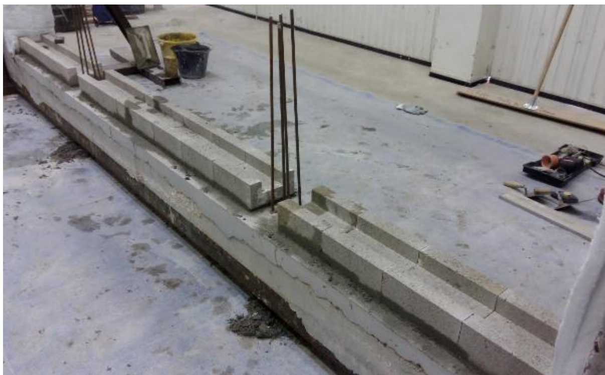
Mise en place du premier rang de semelle en béton et scellement des ancrages dans le cadre d'essai
