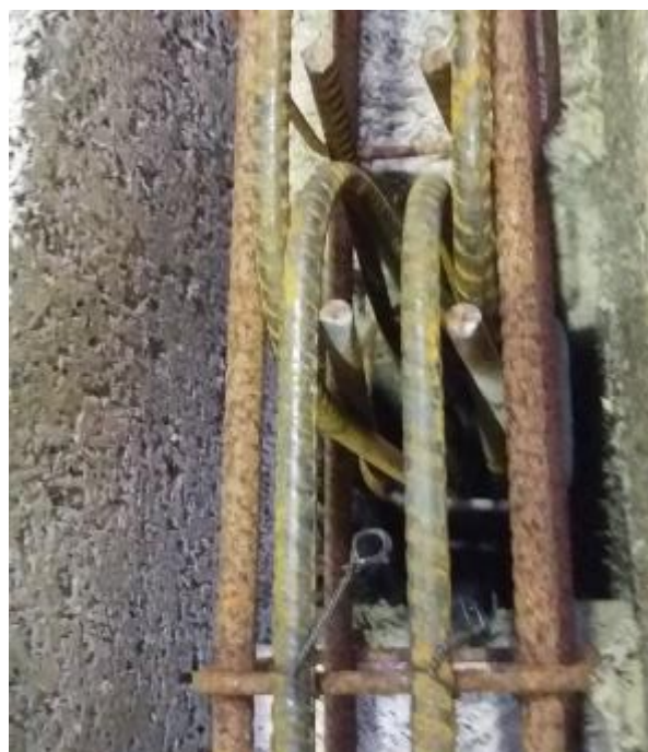
Mise en place des chaînages verticaux, coulage des poteaux et mise en place du chaînage horizontal
