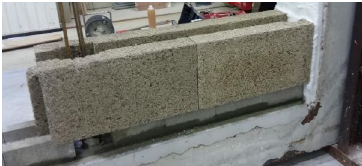
Mise en place des premiers blocs en béton de chanvre
