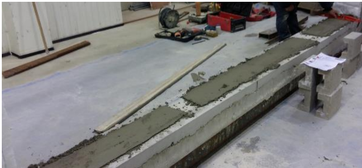
Mise en œuvre de l'arase inférieure et perçage du cadre
