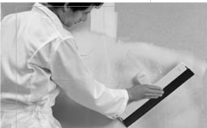
Figure 30 : Application de l'enduit de lissage
