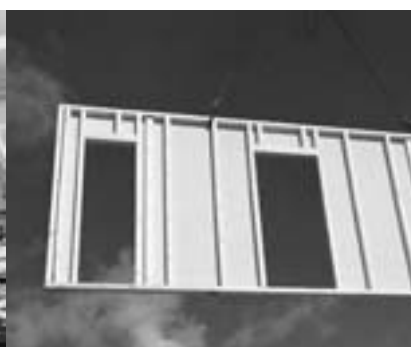
Figure 4 : Transport sur le chantier à l'aide d'une grue
