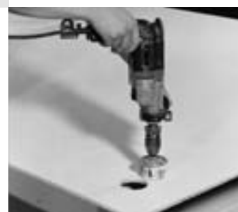
Figure 15 : Exécution des percements pour les prises
