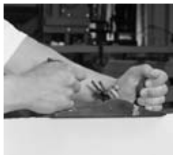
Figure 14 : Robotage de la plaque FERMACELL
