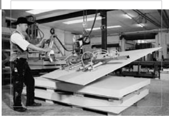
Figure 2 : Transport des plaques FERMACELL avec un appareil de levage à ventouses
