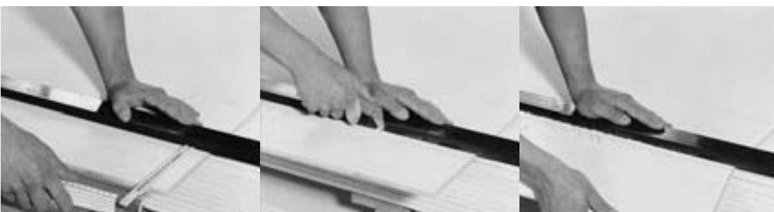
Figure 11 : Détermination de la ligne de rupture
